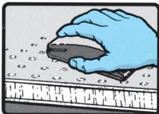
5. Inyecte la mezcla en todos los agujeros practicados en el área deslaminada, haga llegar la mezcla a todas las áreas entre la capa y la superficie interior.
